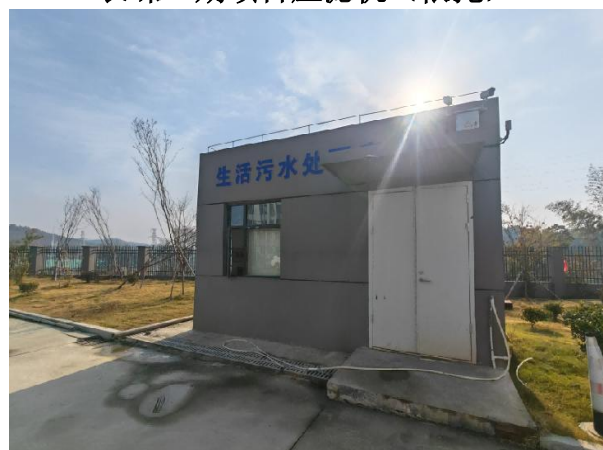
长峡一期项目生活废水处理设施（依托）
