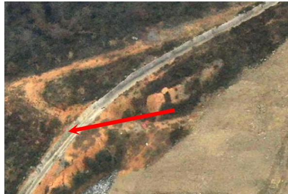
矿区道路周边排水沟
