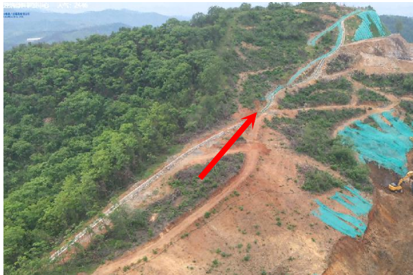
矿区道路周边排水沟
