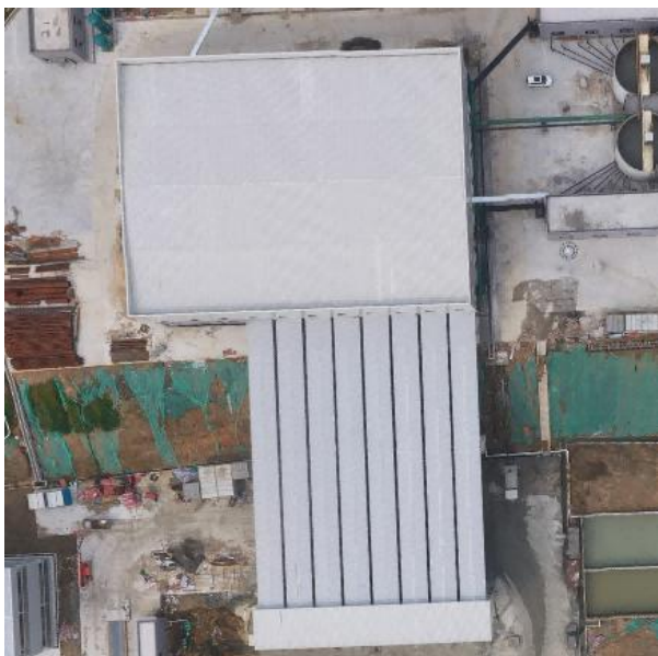
长峡一期项目压滤机房（依托）
