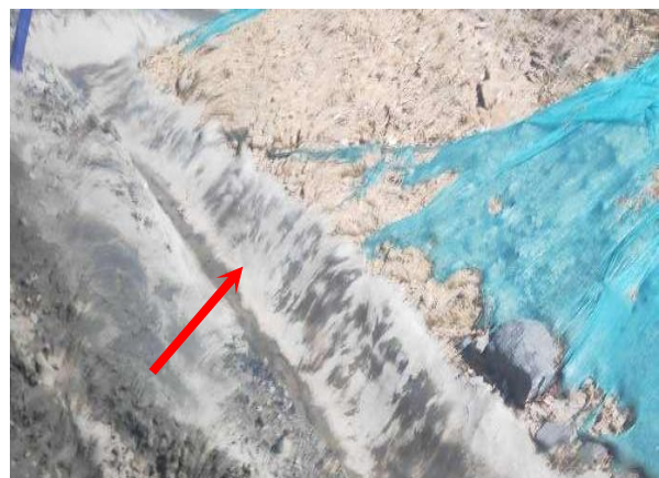
矿区内部排水沟
