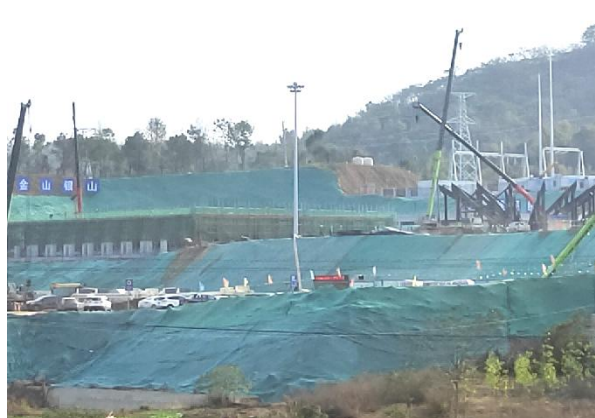
防尘网（施工过程）
