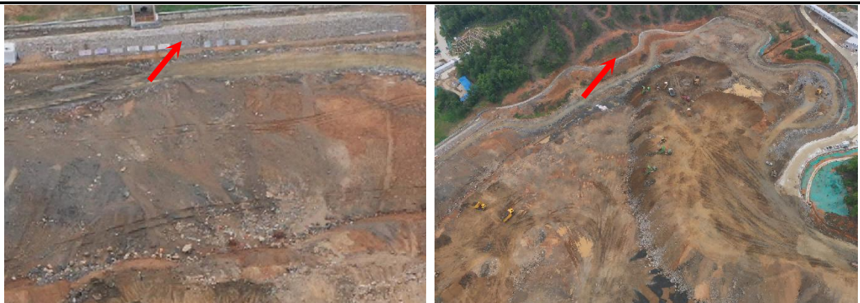
项目排土场挡土墙和截排水沟图
