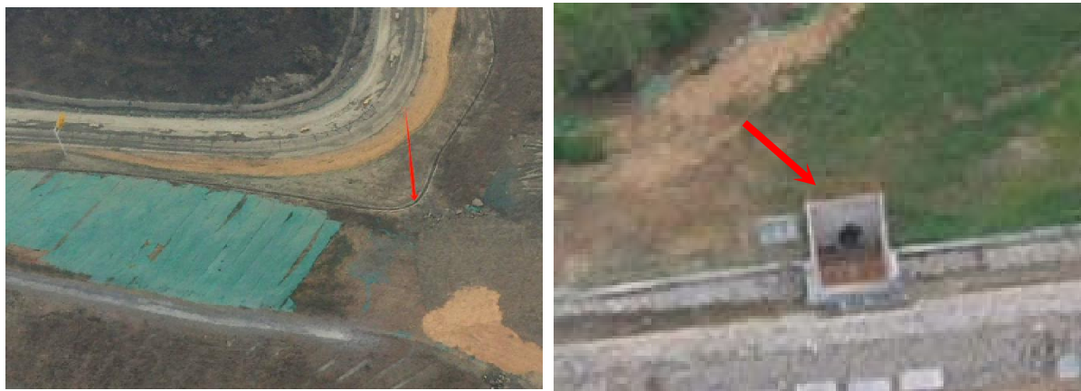
项目排土场区沉沙池图
