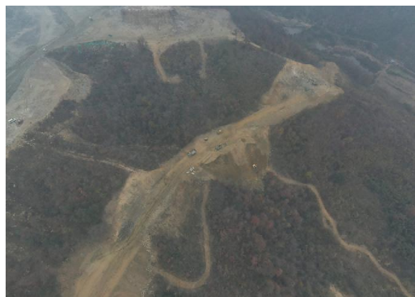
矿区新建道路
